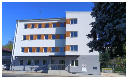
budynek przy ul. Słowackiego 36. po modernizacji
