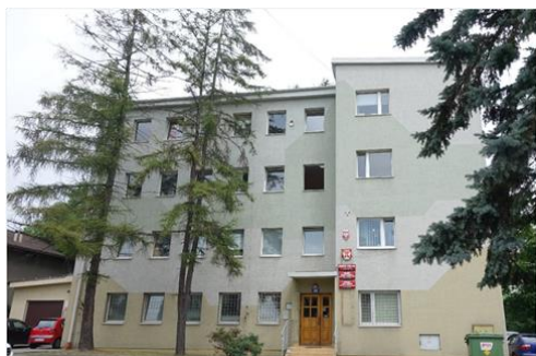
budynek przy ul. Słowackiego 36. przed modernizacją
